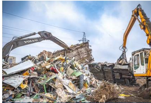
ДЕМОНТАЖ ЗДАНИЙ И МЕТАЛЛОКОНСТРУКЦИЙ
